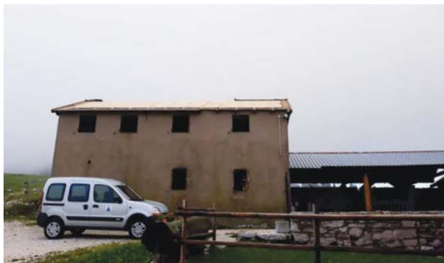
La malga danneggiata dal maltempo.
